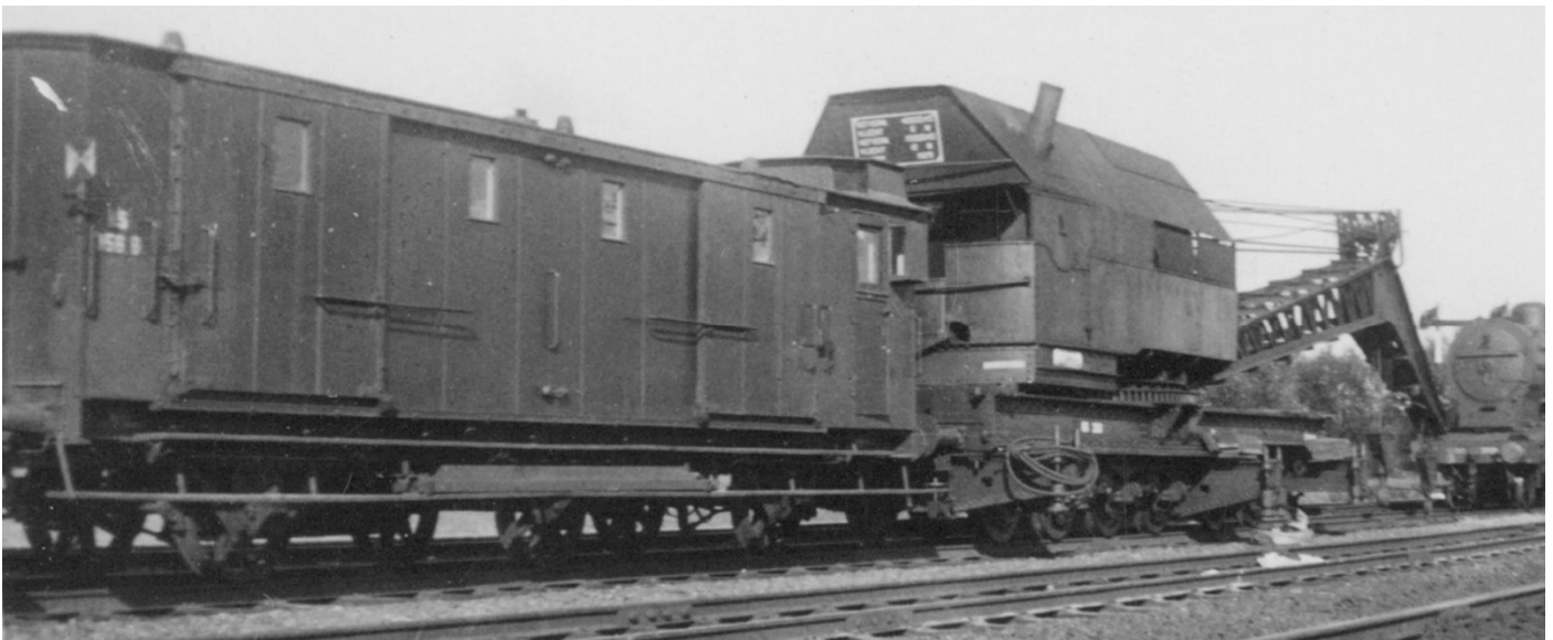
Kraan NS 356 gereed voor opruimwerk te Woerden in 1936. De kraan is voorzien van de stempelbalken die onder de kraanwagen zijn gehangen. De schutwagen is eruit gerangeerd. Foto J. Bonthuis
