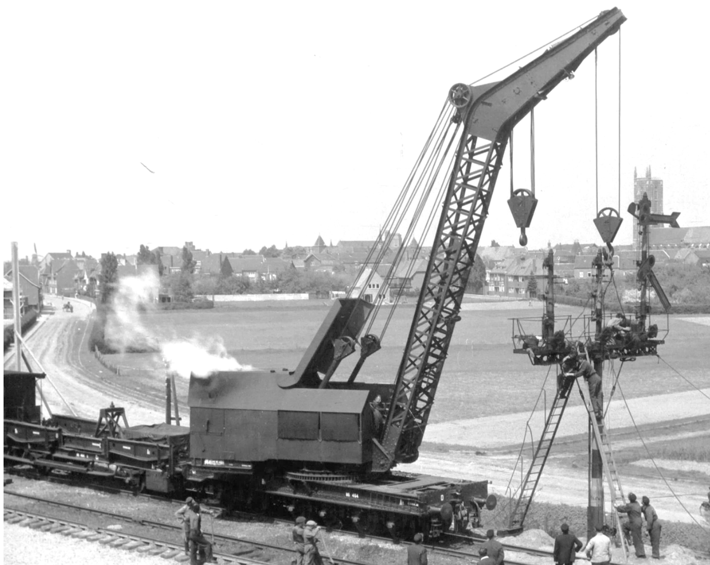
NS 455 ingezet voor werkzaamheden aan de bovenleiding te Roosendaal op 21-5-1963. Erachter de extra waterwagen. Foto J. Bonthuis
